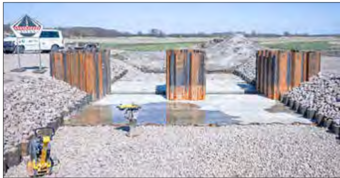
Die Spundwände zeigen schon, in welcher Dimension das neue Wehr entsteht Foto: Stefan Rühling
