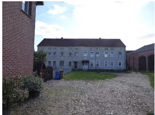
OT Grävenitz – Blick auf Wohnhaus Dorfstraße 19
