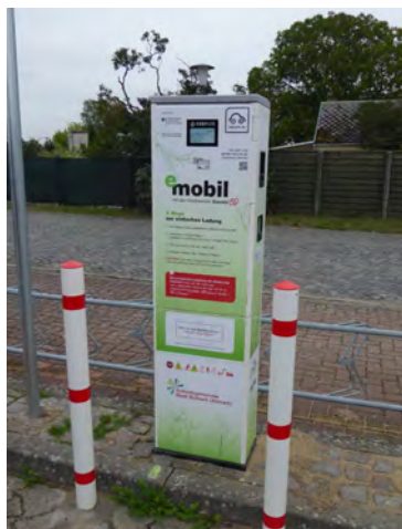
Abbildung 63: E-Ladesäule für PKWs am Freibad „Kolk“
